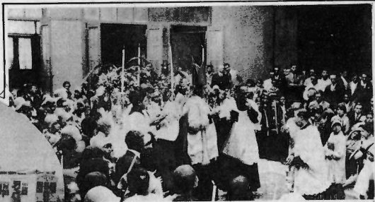
QUEZALTENANGO.—El Ilmo. señor Obispo de Los Altos, Monseñor Jorge GARCIA, bendiciendo la Estación del Ferrocarril, el día de inaugurarse el servicio público.
